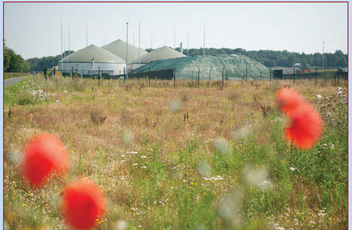
Biogasanlage, Bild von RheinEnergie Biokraft Randkanal-Nord GmbH & Co.KG; Aufnahme vom 26. Juli 2012
