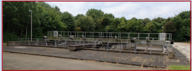
Regenüberlaufbecken auf dem Gelände des ehemaligen Klärwerkes Pulheim; Aufnahme vom 20. Juli 2013
