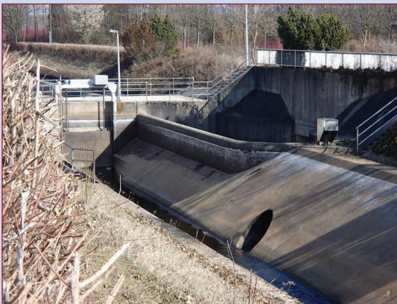
Kanal mit Drosselbauwerk, Überfallkante, Ableitungsöffnung; Aufnahme vom 3. April 2013
