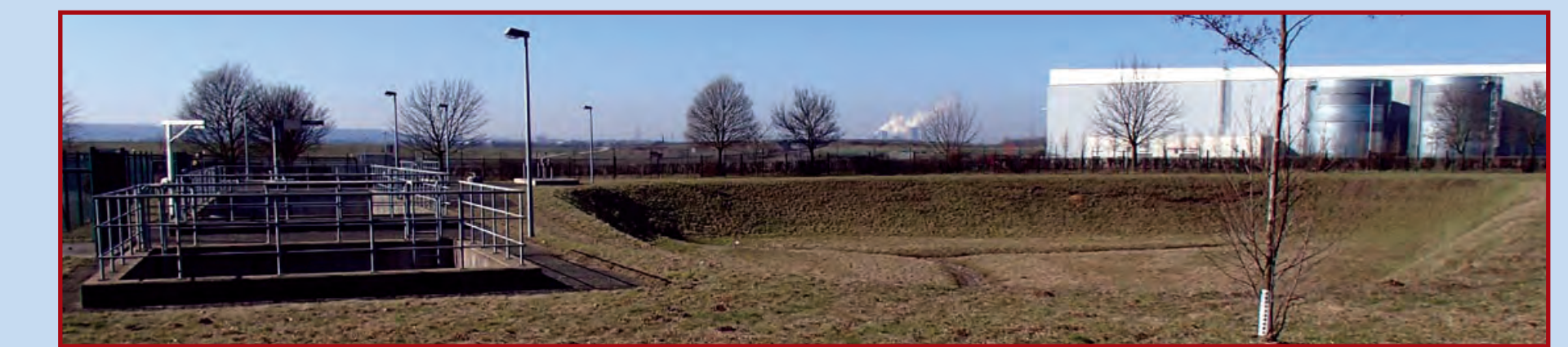
Regenklärbecken (links im Bild) und Regenrückhaltebecken (rechts im Bild) Gewerbegebiet "Am Schwefelberg"; Aufn. vom 4. März 2013
