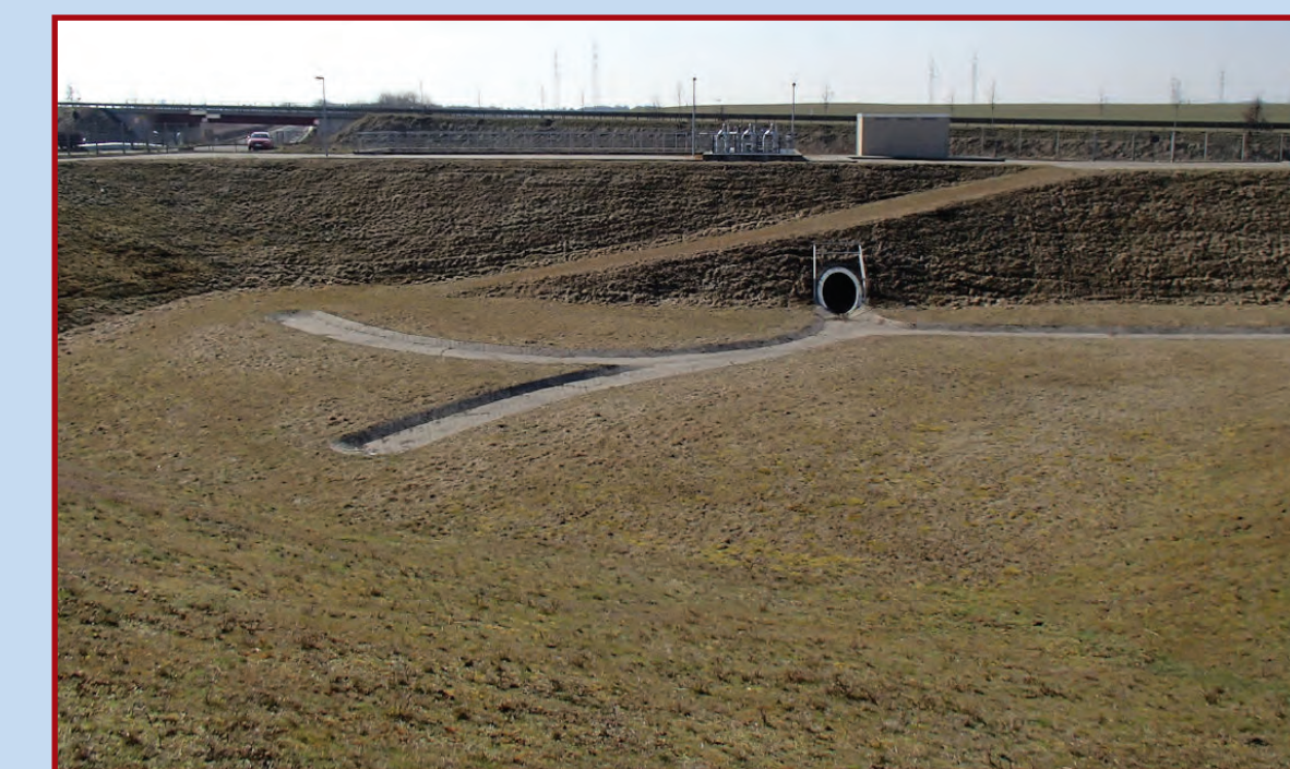
Regenrückhaltebecken Gewerbegebiet "Am Schwefelberg"; Aufnahme vom 2. April 2013
