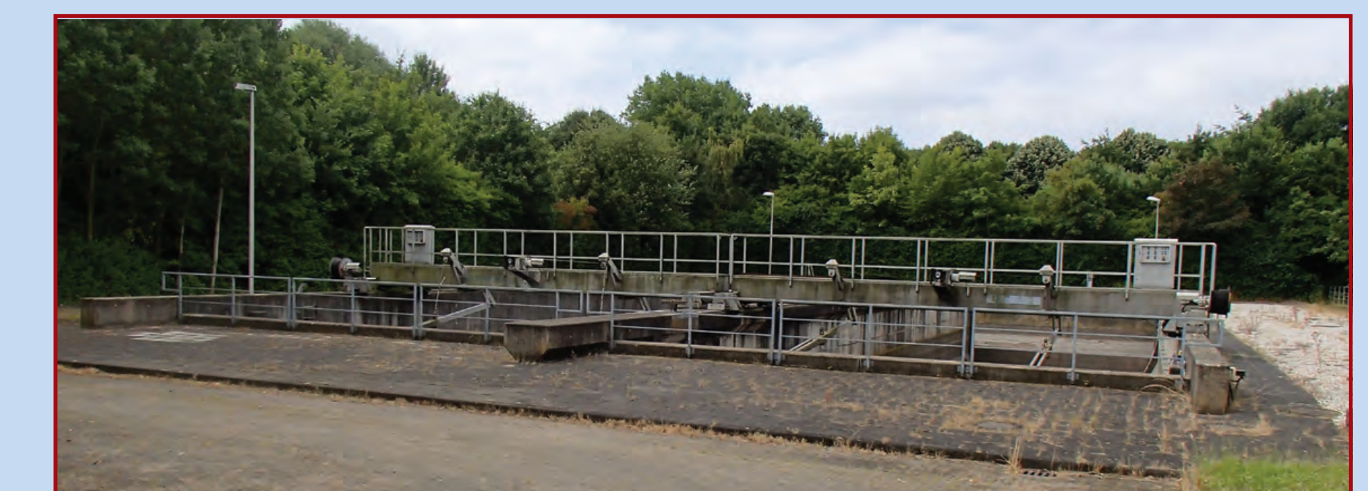
Regenüberlaufbecken auf dem Gelände des ehemaligen Klärwerkes Pulheim; Aufn. vom 20. Juli 2013
