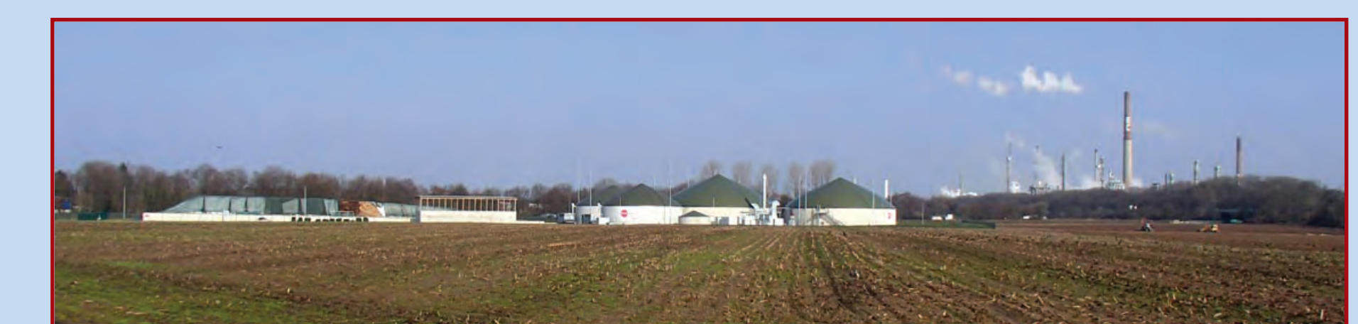
Biogasanlage; Aufnahme vom 22. März 2013
