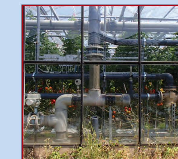
Gewächshäuser mit erwärmter Luft (Hortitherm-Verfahren) Aufnahmen 23. Juli 2013
