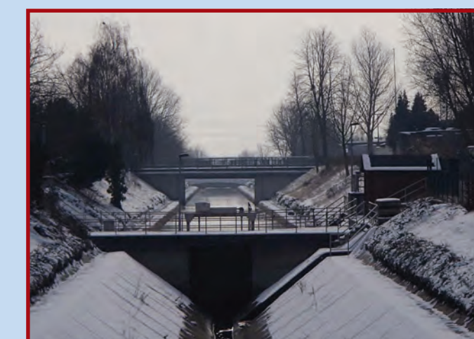
Drosselbauwerk für Stau und Wasserkraftanlage; 24. Januar 2013
