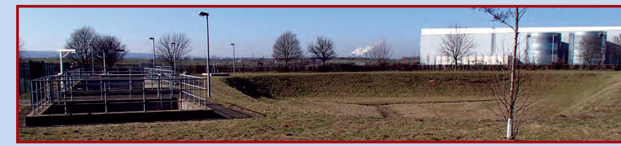
Regenklär- und Regenrückhaltebecken
